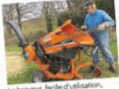
Le broyeur, facile d'utilisation, sur un chantier récent.
